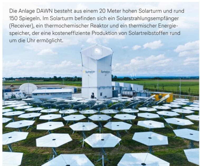
Die Anlage DAWN besteht aus einem 20 Meter hohen Solarturm und rund 150 Spiegeln. Im Solarturm befinden sich ein Solarstrahlungsempfänger (Receiver), ein thermochemischer Reaktor und ein thermischer Energiespeicher, der eine kosteneffiziente Produktion von Solartreibstoffen rund um die Uhr ermöglicht.
